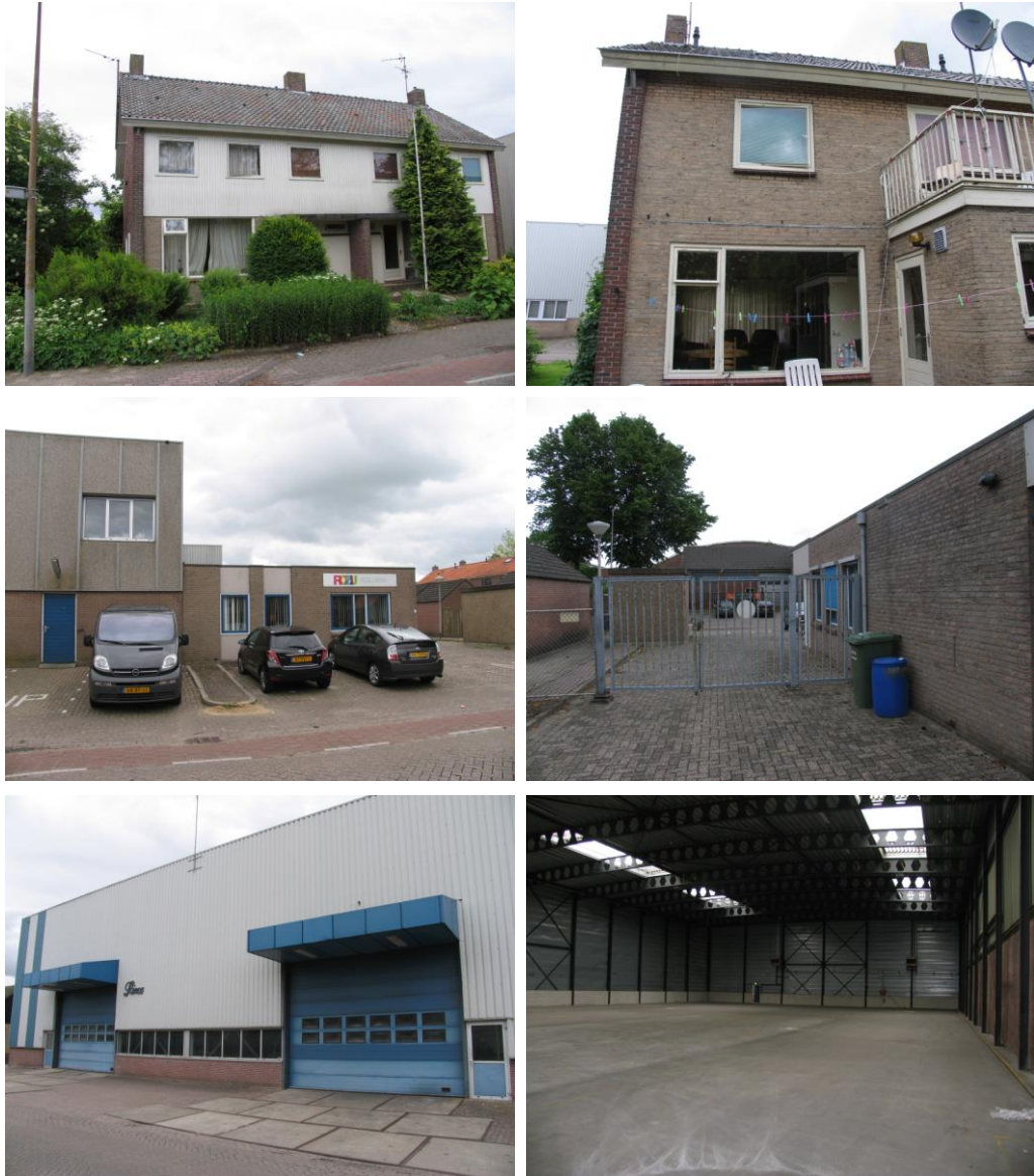
Afbeelding 2: Globale indruk plangebied. Van linksboven naar rechtsonder: Voorkant woningen, achterzijde woningen, kantoor met deel loods, zijkant kantoor, loodscomplex, binnenzijde loodscomplex.
