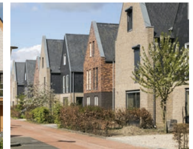
Afwijkende kleur/metselwerk op de verdiepingen
