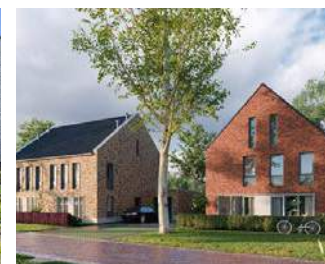
Gevels achter het dakvlak
