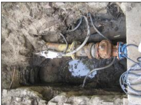
Foto's 17 en 18: rioolafsluiter in persleiding en reiniging persleiding
