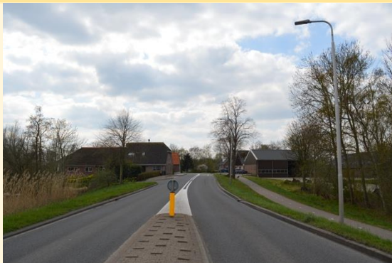
Versterken oostelijke entree (Kamperzeedijk-oost)
