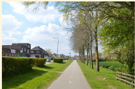
Herstellen historische dijkprofiel (Kamperzeedijk-oost)
