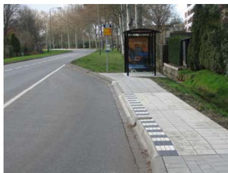
Bushalte conform het provinciale PvE
